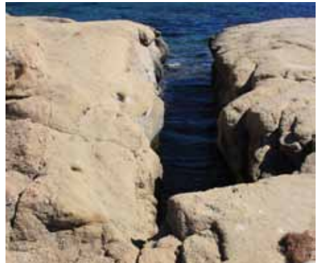
Figura 25. Aspecto actual de una fractura erosionada por el mar. Su relleno posterior de la parte sumergida formaría en el futuro un dique neptúnico.
